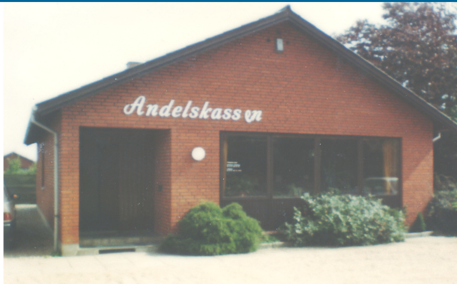
Faster Andelskasse før ombygning i 80'erne
